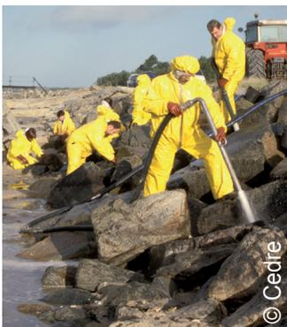
« Flushing » sur enrochements
